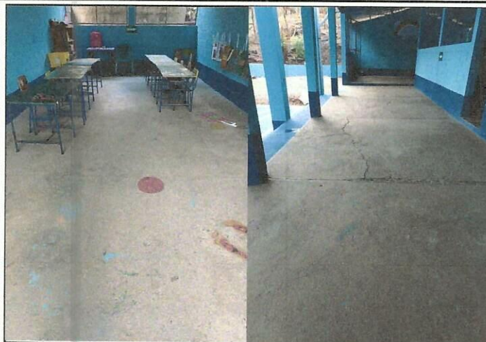
Foto1: Se realizará instalación de piso en el corredor de la escuela y aula de Párvulos.
